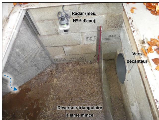
Vue du système de mesure des débits du trop-plein du captage
