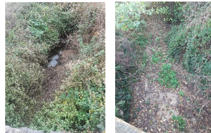
Figure 23 : Photographies du ruisseau d'Angèles (à gauche) et du ruisseau de La Grange (à droite)- Photo OFB
