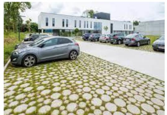
Figure 21: Présentation de l'infiltration par enrobé poreux et photographie présentant un parking avec des dalles engazonnées
