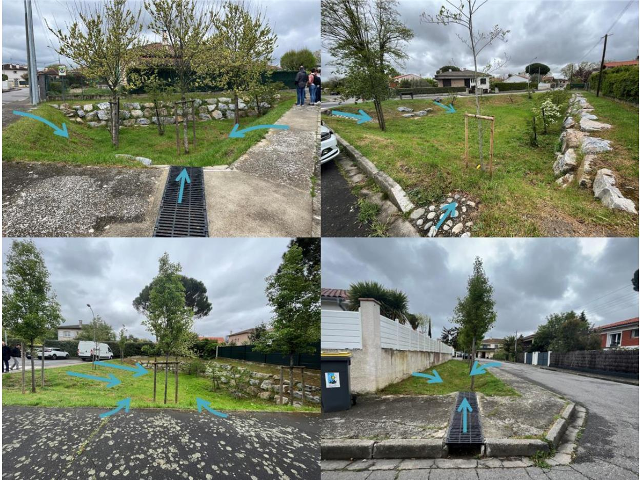
Figure 31: Photographie des aménagements de Portet-sur-Garonne (bassins d'infiltration et noues)
